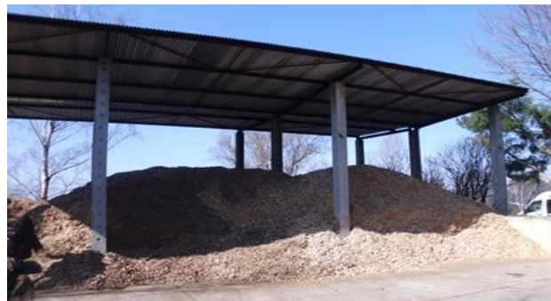
Abbildung: Heizwerk Waldrestholz in Uebigau-Wahrenbrück
